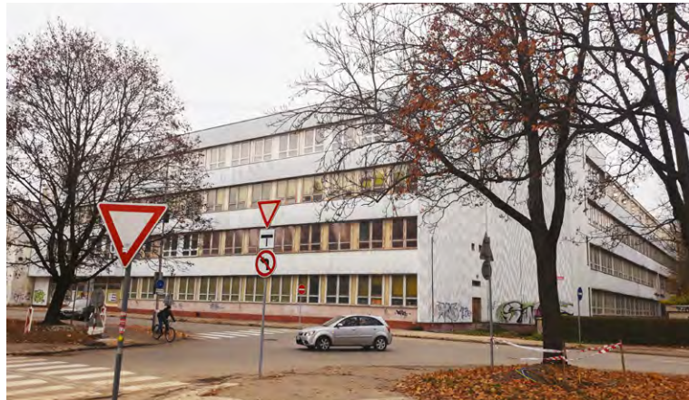
Toto bude klientske centrum štátnej správy, biely rohový objekt na Ul. M. R. Štefánika a Thurzovej ul.
