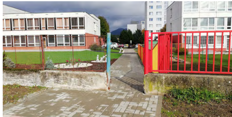
Zrekonštruovaný chodník pred MŠ a súkromnou ZUŠ
