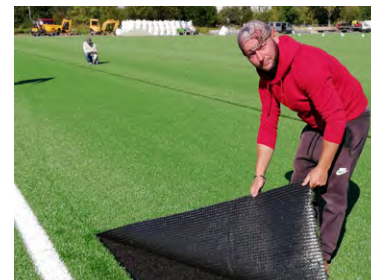
Na dôkladne pripravenú plochu položili umelý trávnik najnovšej generácie. Foto: Ich
