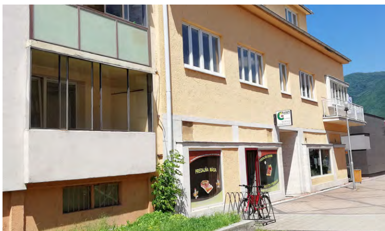
V tejto žltej budove bývalej knižnice Hany Zelinovej bude po rekonštrukcii zriadená stála historická expozícia železničarských Vrútok. Foto: Ich
