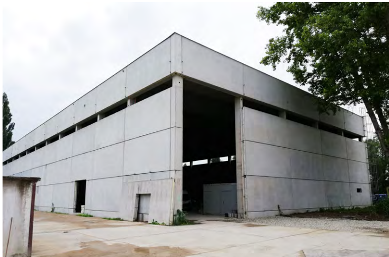
Rozostavaná tréningová hokejová hala čaká už dlho na dokončenie. Foto: l'ch
