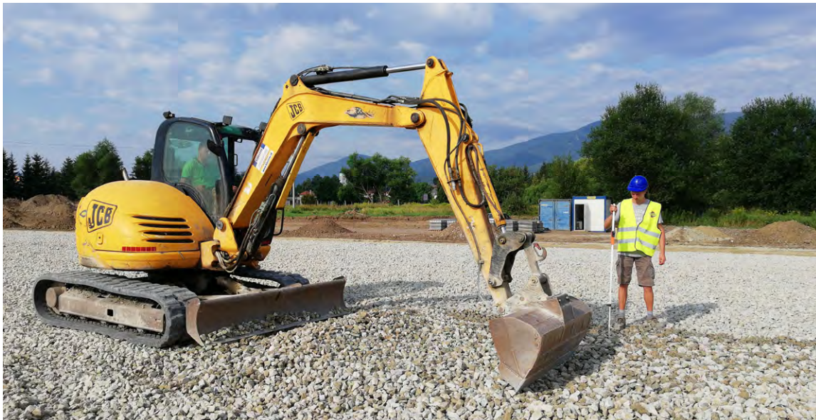
Na Pltníkoch sa pracuje na realizácii budúceho futbalového ihriska
