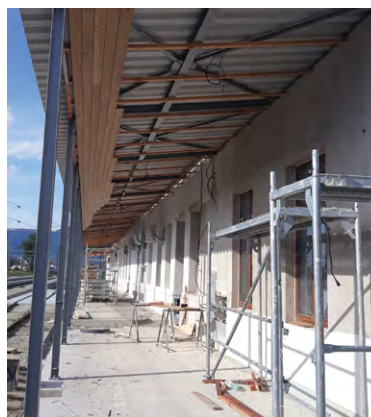
Na nástupíšte príde dlažba a hore podhl'ad, vyvýšené nástupíštia a priechody sú hotové.
