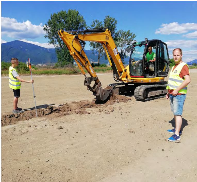
So stavbyvedúcim Michalom Kosmeľom (vpravo) 15. júla na stavenisku, kde vyrastie futbalové ihrisko s umelou trávou
