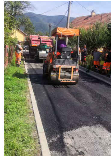
Obnova Poľnej ulice. Foto: mesto Vrútky
