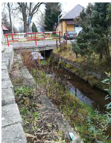
Most ponad odvodňovací kanál. Foto: pt
