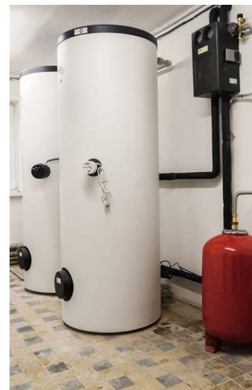
Na futbalovom štadióne urobili rekonštrukciu systému prípravy teplej vody. Foto:mv
