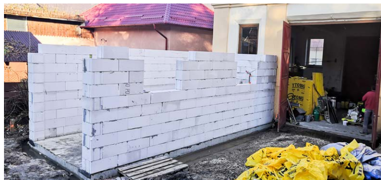
Prístavba a stavebné úpravy hasičskej zbrojnice. Foto:mv
