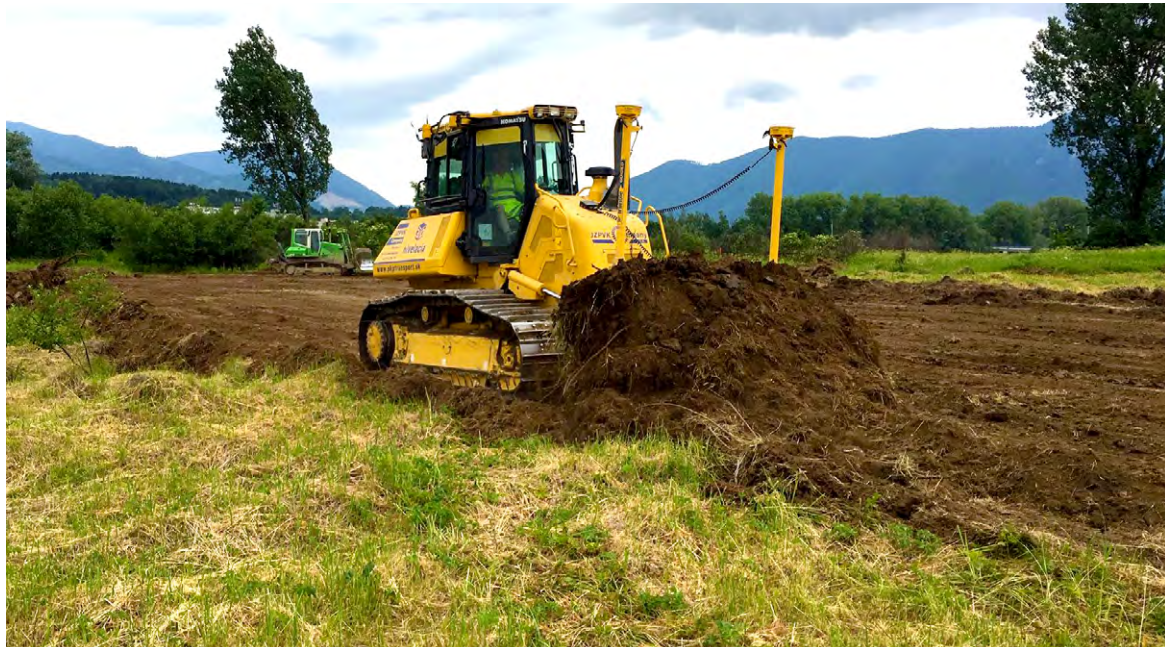
Stavebné mechanizmy začali s hrubými terénnymi úpravami na prípravu staveniska na Ptlníkoch
