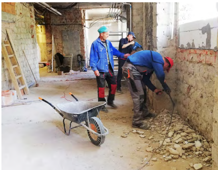
Rekonštrukcia žiackych šatní na zimnom štadióne je v plnom prúde. Foto: lch
