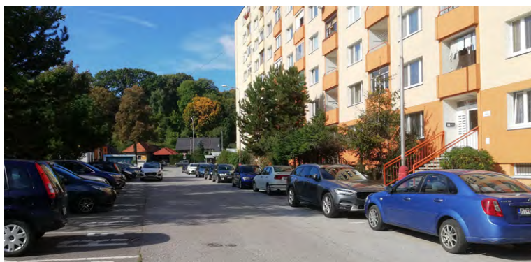
Na Ul. Alberta Mamateja v Záturčí parkujú autá kolmo a aj pozdĺžne. Ak sa má zachovať pozdĺžne parkovanie, tak sa z tejto ulice zrejme musí stať jednosmerka. Foto: l'ch
