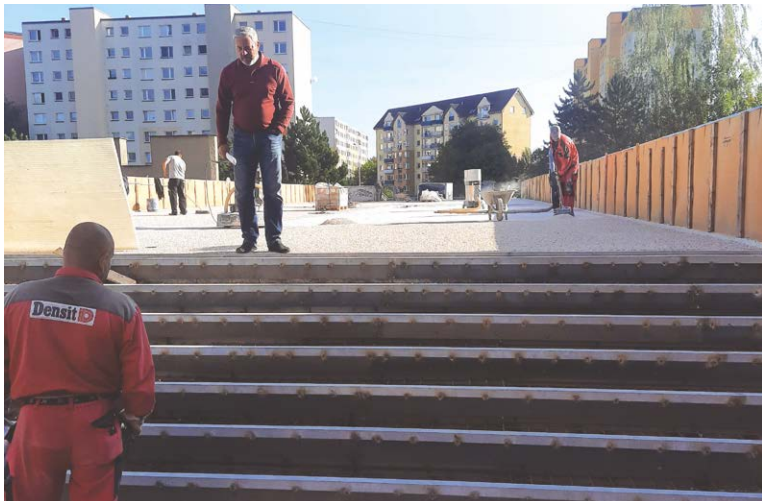
Riaditeľ f. Densit SK J. Barta (hore) kontroluje prípravu formy pre nové schodište.
