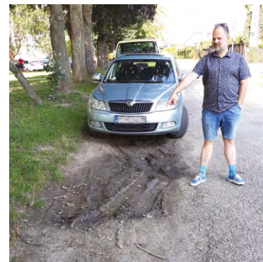
M. Lechan pri pripravovanom rozšírení parkovacích plôch na Starej Ľadovni.
