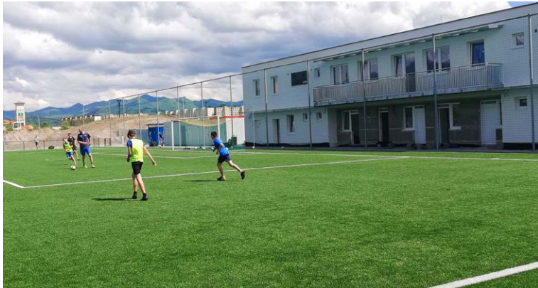
Dominantou Šport parku Pltníky je futbalový areál, kde dokončujú administratívnu budovu. Foto: ICh
