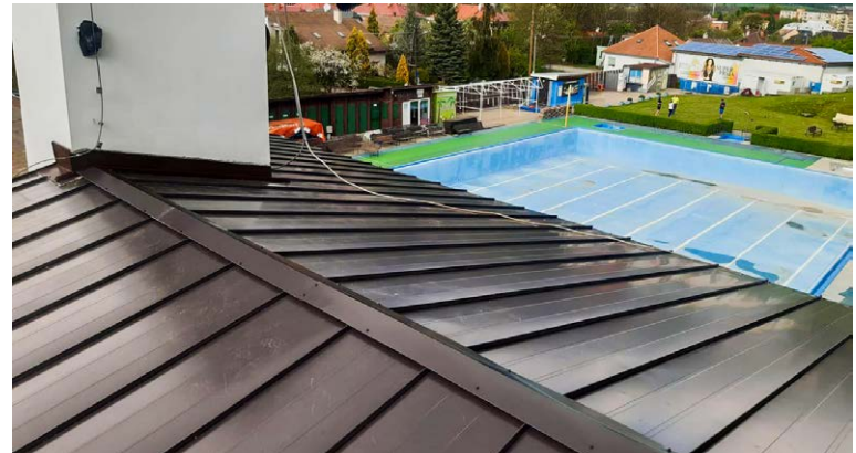
Nová strecha na budove na kúpalisku. Foto: vt
