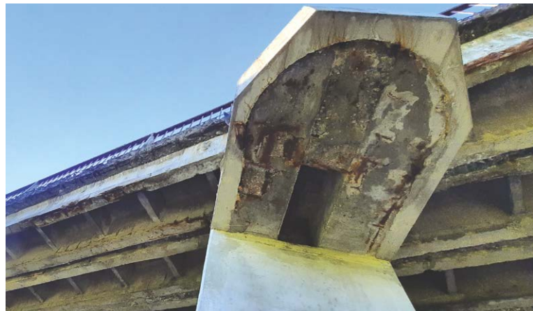
Sanácia spodnej konštrukcie - zvislých nosníkov
