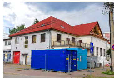
Rekonštrukcia kultúrneho domu napreduje. Foto: lch
