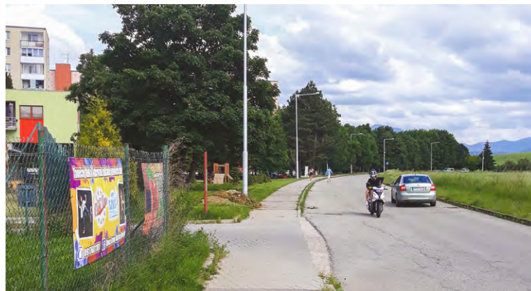
Na ceste do Jahodníckych hájov nad odbočkou k Lackovcom (vľavo) bude osadená značka, zakazujúca vjazd po 19. h (vozidlá na fotografii sú približne v čiare značky).
