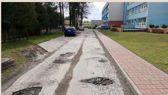
Výtlky na ceste k ZŠ s MŠ Hurbanova treba po zime opraviť
