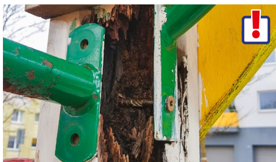
RIEŠIME: nebezpečne poškodené hracie prvky na Kronerovej ul.
