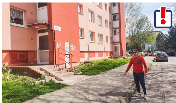
RIEŠIME: nebezpečný sklon chodníka na Majakovského ul.
