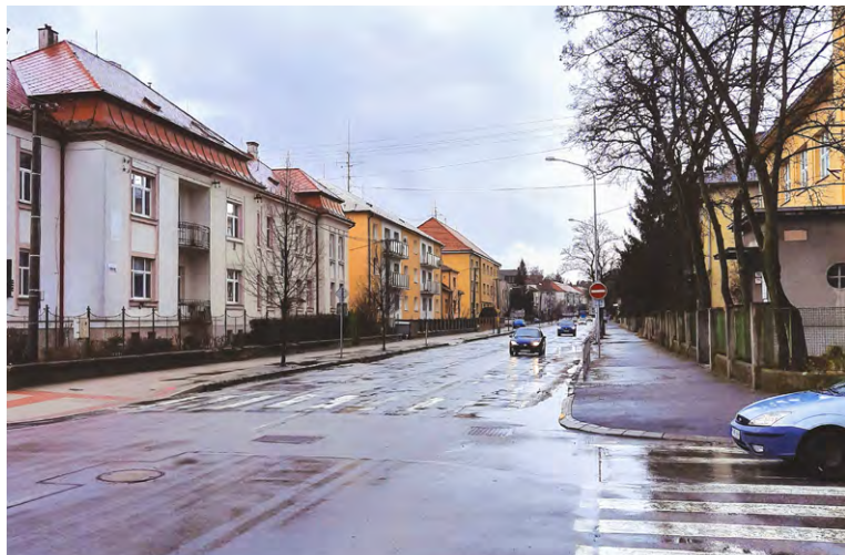
Od hranice križovatky vidno „tankodrom“ Hviezdoslavovej ul. (a pod ním je čas vymeniť horúcovod)
