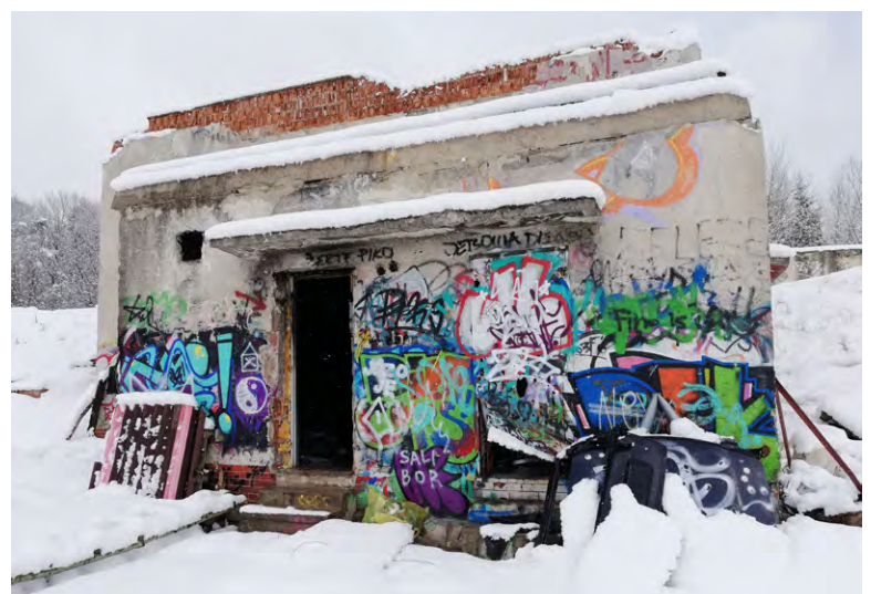
Dvere do zdevastovaného objektu vodárne neboli zamurované. Foto: l'ch
