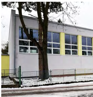
Exteriér telocvične je hotový, dokončiť treba ešte interiér. Foto: l'ch
