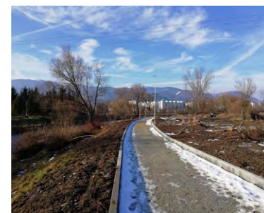
Budovaný martinský úsek. Foto: lch
