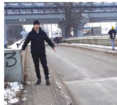
Úzke chodníky na moste sú nebezpečné
