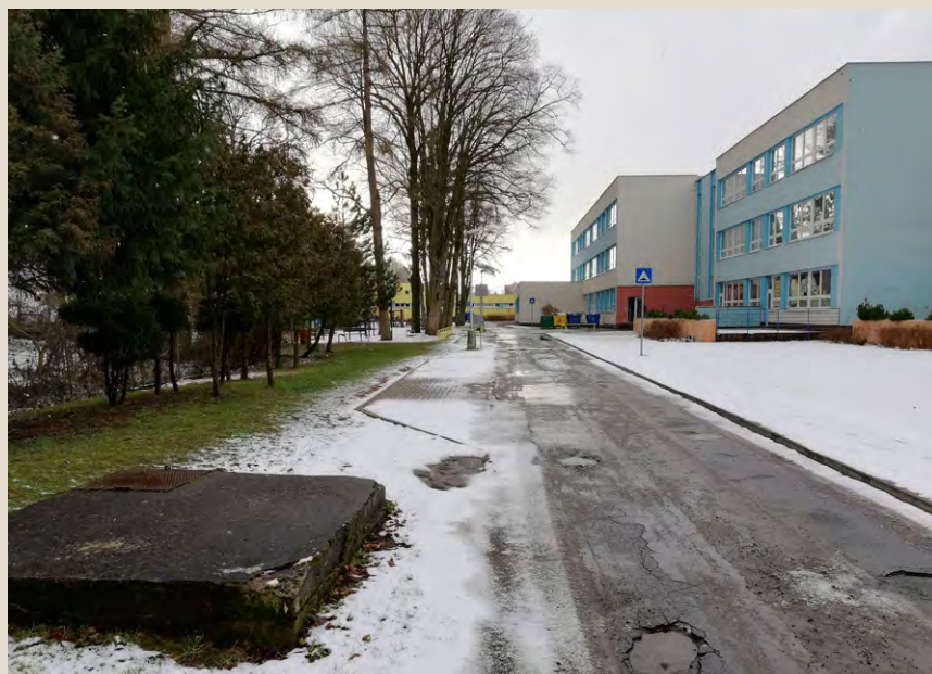
Prístupovú cestu k ZŠ s MŠ Hurbanova čaká rekonštrukcia
